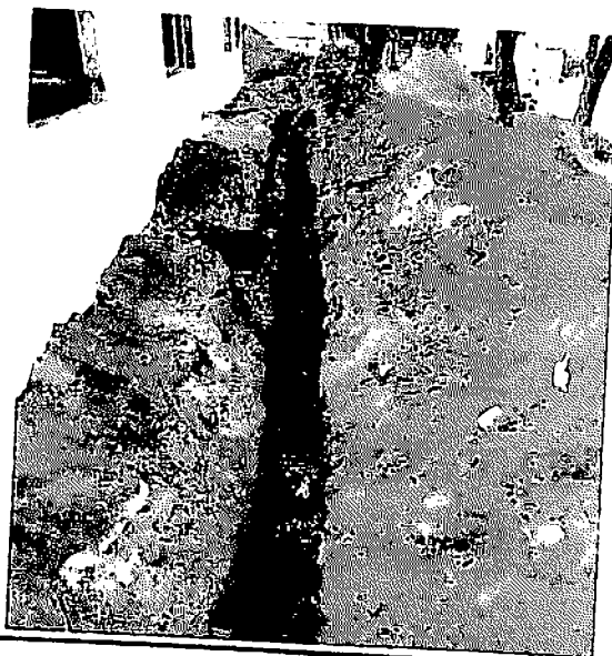
Foto 40: escavação rede esgoto.
